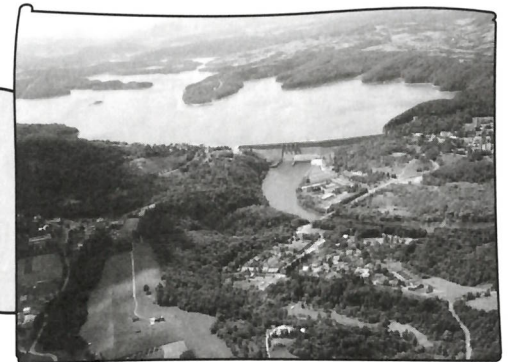
SOLINA NA RZECE SAN, uruchomiony w 1968 r., pojemność: 472,4 mln m 3 , powierzchnia: 22 km 2 .
